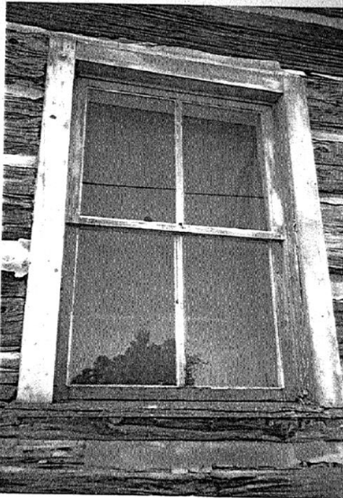
Single sash window/Fenêtre à guilotine
